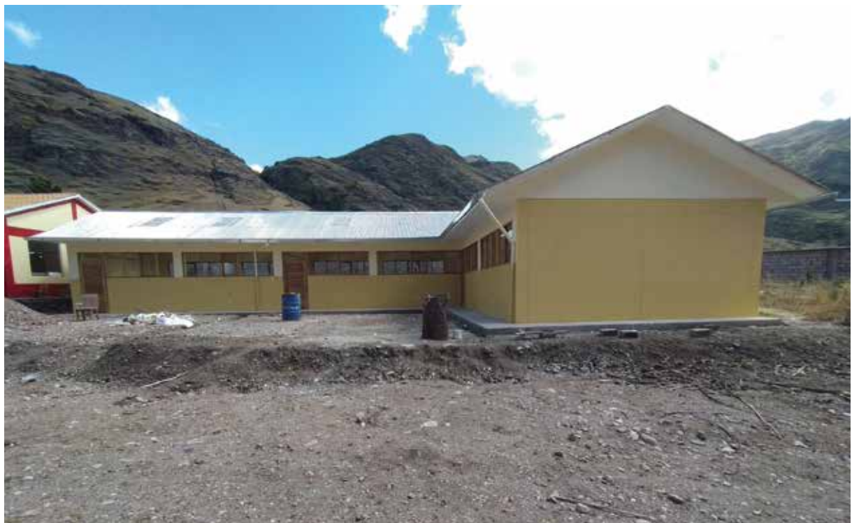
Bouw van drie klaslokalen van de school in Huacahuasi.
